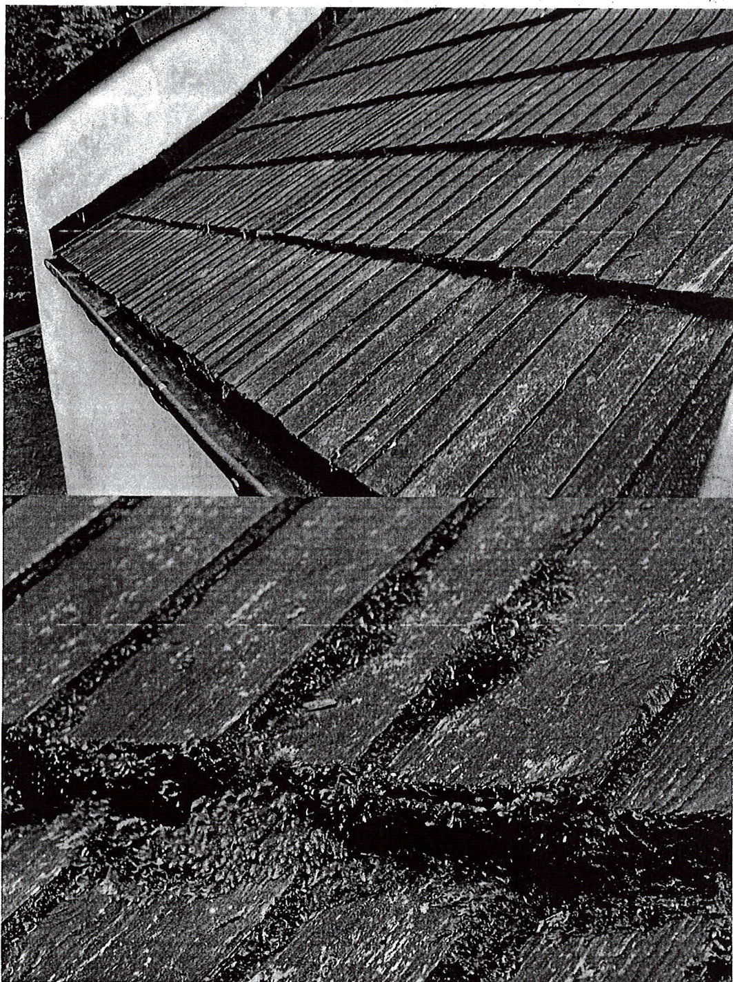
Fot.7-8. Kościół parafialny w Zbyszycach. Stan zachowania pokrycia dachowego ;grudzień 2023 r.
